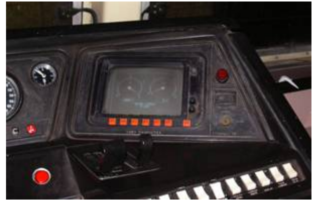
Particolare del Banco di guida della E652 158. Il monitor della Diagnostica.
